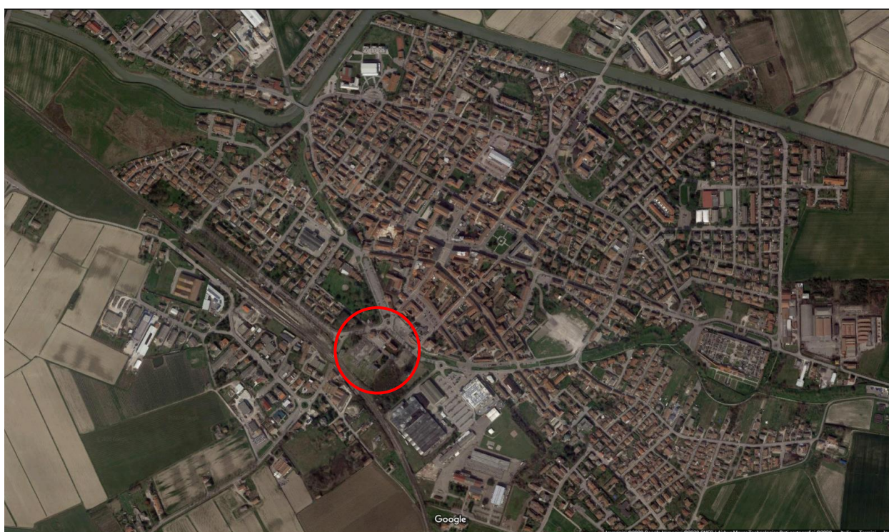
Individuazione della centrale elettrica di Portomaggiore (Foto aerea di Googlemap)
