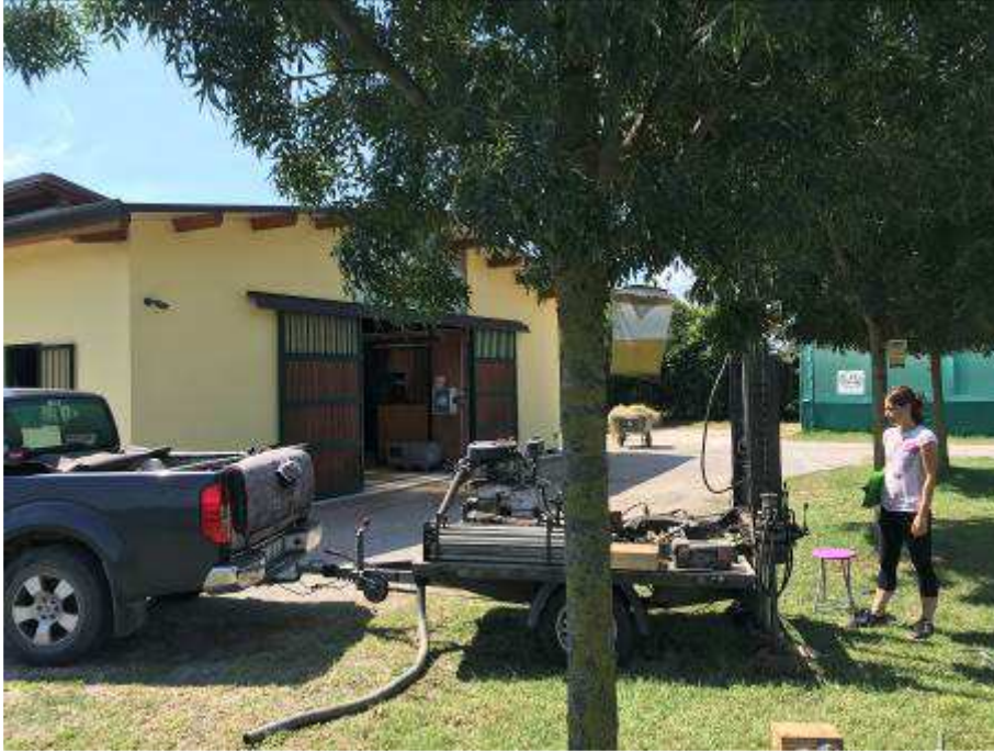
Fig. 2/38: punto di esecuzione della C.P.T. 5.
