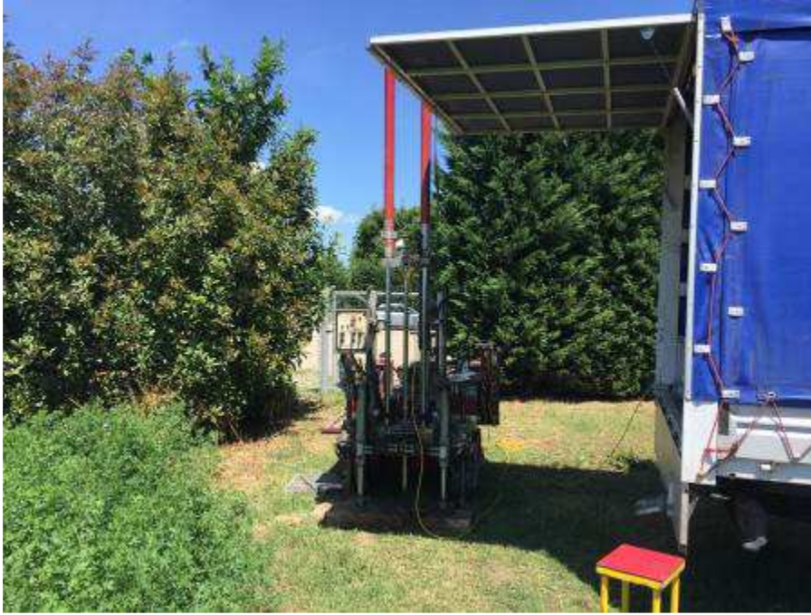
Fig. 2/36: punto di esecuzione della S.C.P.T.U. 2.
