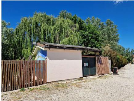
FOTO N. 19 - CENTRALE TERMICA (centrale termica oggetto di demolizione, zona nord-est Lago Tramonto)
