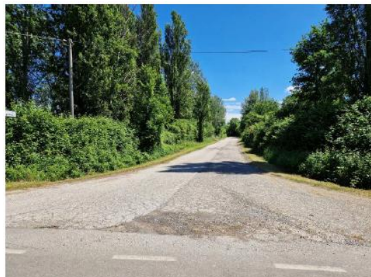
FOTO N. 26 - VIA BARGELLESÌ (tratto stradale oggetto di realizzazione di nuovi parcheggi)
