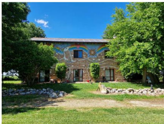
FOTO N. 5 - EDIFICIO N. 5 "CA' MAMA" (non oggetto di trasformazioni)
