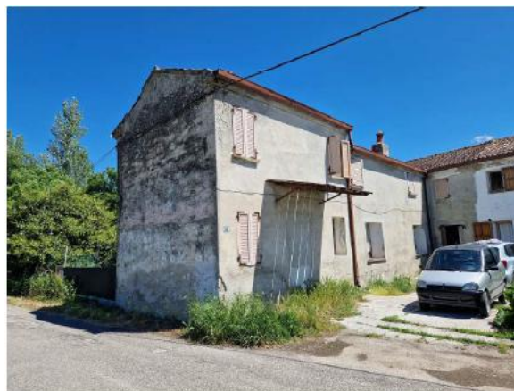
FOTO N. 6 - EDIFICIO N. 6 "CA' BUDGHIN" (non oggetto di trasformazioni e non utilizzato)
