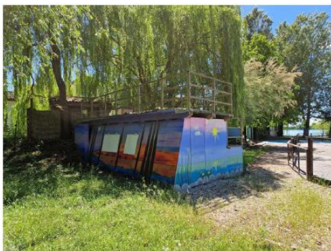
FOTO N. 21 - VANO TECNICO PISCINA (vano tecnico oggetto di rimozione, zona nord-est Lago Tramonto)
