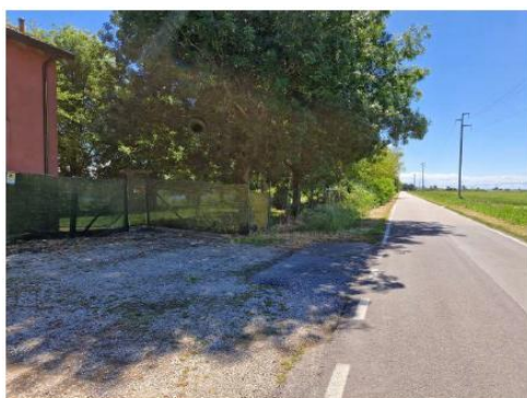
FOTO N. 27 - VIA VERGINESE (tratto stradale oggetto di realizzazione di nuovi parcheggi)
