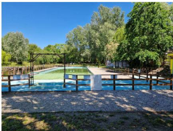
FOTO N. 17 - AREA PISCINA/BIOLAGO (piscina oggetto di demolizione e risagomatura biolago, zona nord-est Lago Tramonto)
