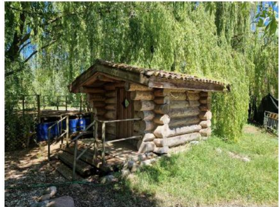
FOTO N. 20 - SAUNA (sauna oggetto di rimozione, zona nord-est Lago Tramonto)
