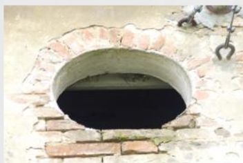
Bucatura ellittica in edificio di abitazione
