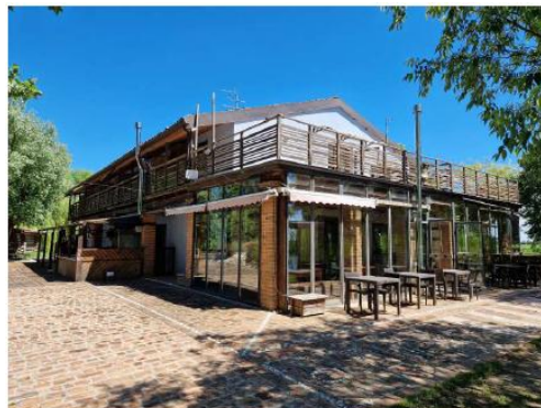
FOTO N. 4- EDIFICIO N. 4 "CA' VENERE" (oggetto di ristrutturazione del bar - ristorante al piano terra e dei n. 5 alloggi al piano primo)
