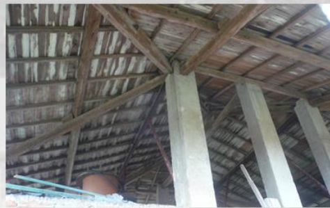
Copertura lignea e pilastri intonacati
