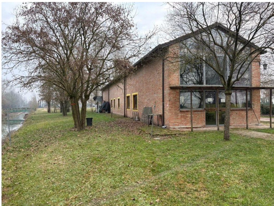
Figura 7- Ca' Longa – Prospetto nord-ovest / Fronte sud-ovest
