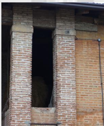
Pilastri di mattoni faccia a vista
