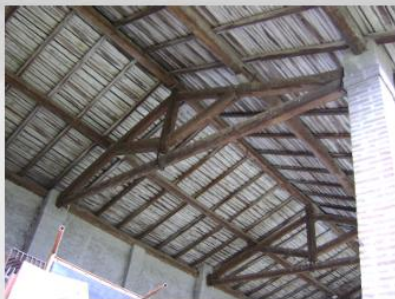
Copertura lignea e mattoni a vista
