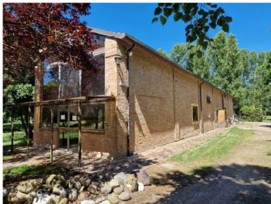
FOTO N. 1 - EDIFICIO N. 1 "CA' LONGA" (oggetto di ristrutturazione per realizzazione n. 6 alloggi)
