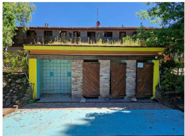
FOTO N. 18 - SERVIZI IGIENICI PISCINA/BIOLAGO (servizi igienici oggetto di demolizione, zona nord-est Lago Tramonto)
