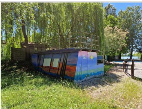
FOTO N. 9 - VANO TECNICO PISCINA (vano tecnico oggetto di rimozione, zona nord-est Lago Tramonto)
