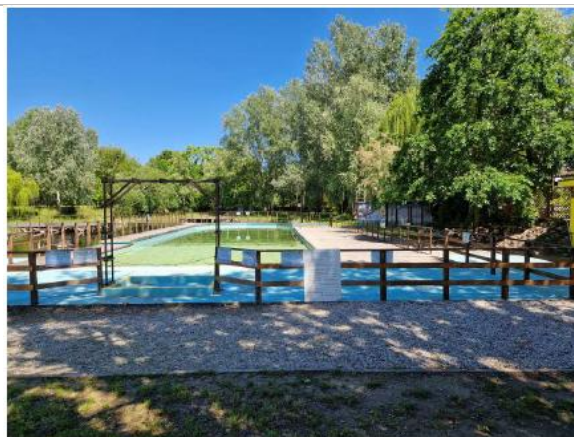
FOTO N. 8 - AREA PISCINA/BIOLAGO (piscina oggetto di demolizione e risagomatura biolago, zona nord-est Lago Tramonto)
