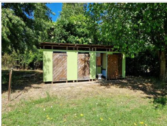
FOTO N. 3 - SERVIZI IGIENICI (servizi igienici oggetto di rimozione, zona nord Lago Tramonto)
