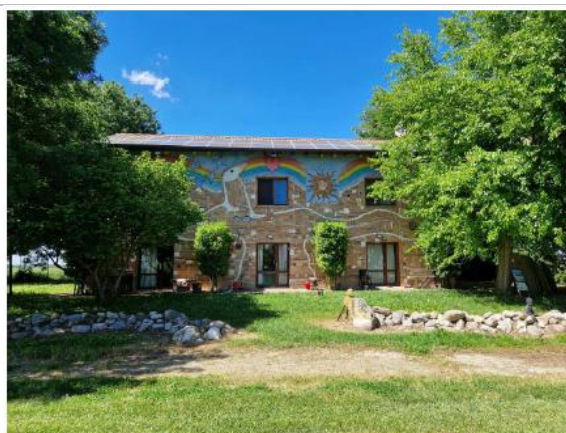
FOTO N. 18 - EDIFICIO N. 5 "CA' MAMA" (non oggetto di trasformazioni)
