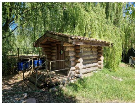
FOTO N. 10 - SAUNA (sauna oggetto di rimozione, zona nord-est Lago Tramonto)
