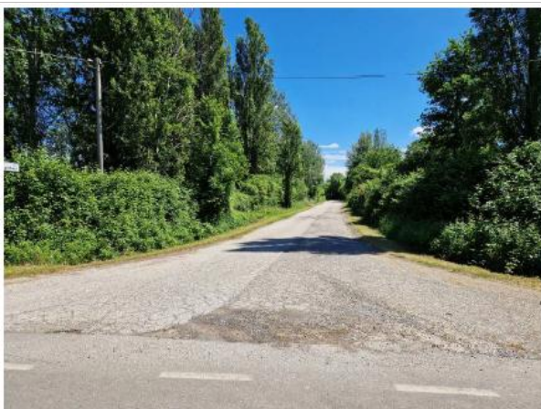
FOTO N. 1 - VIA BARGELLES (tratto stradale oggetto di realizzazione di nuovi parcheggi)
