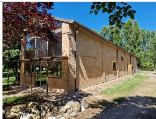
FOTO N. 4 - EDIFICIO N. 1 "CA' LONGA" (oggetto di ristrutturazione per realizzazione n. 6 alloggi)
