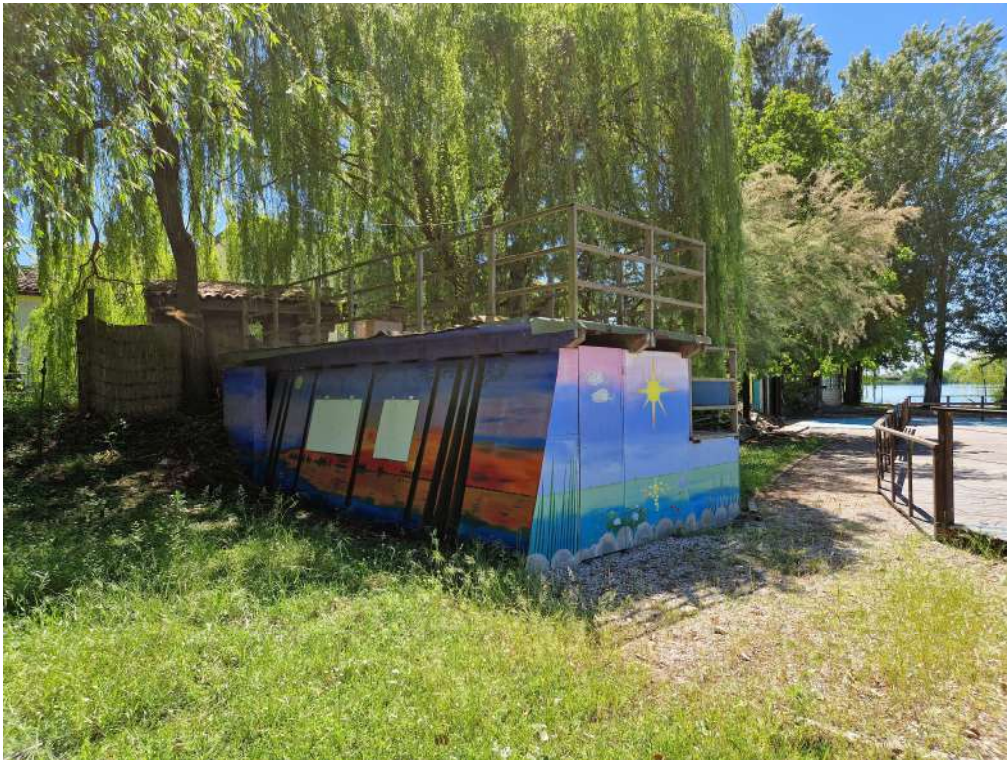
FOTO N. 21 VANO TECNICO PISCINA (vano tecnico oggetto di rimozione, zona nord-est Lago Tramonto)
