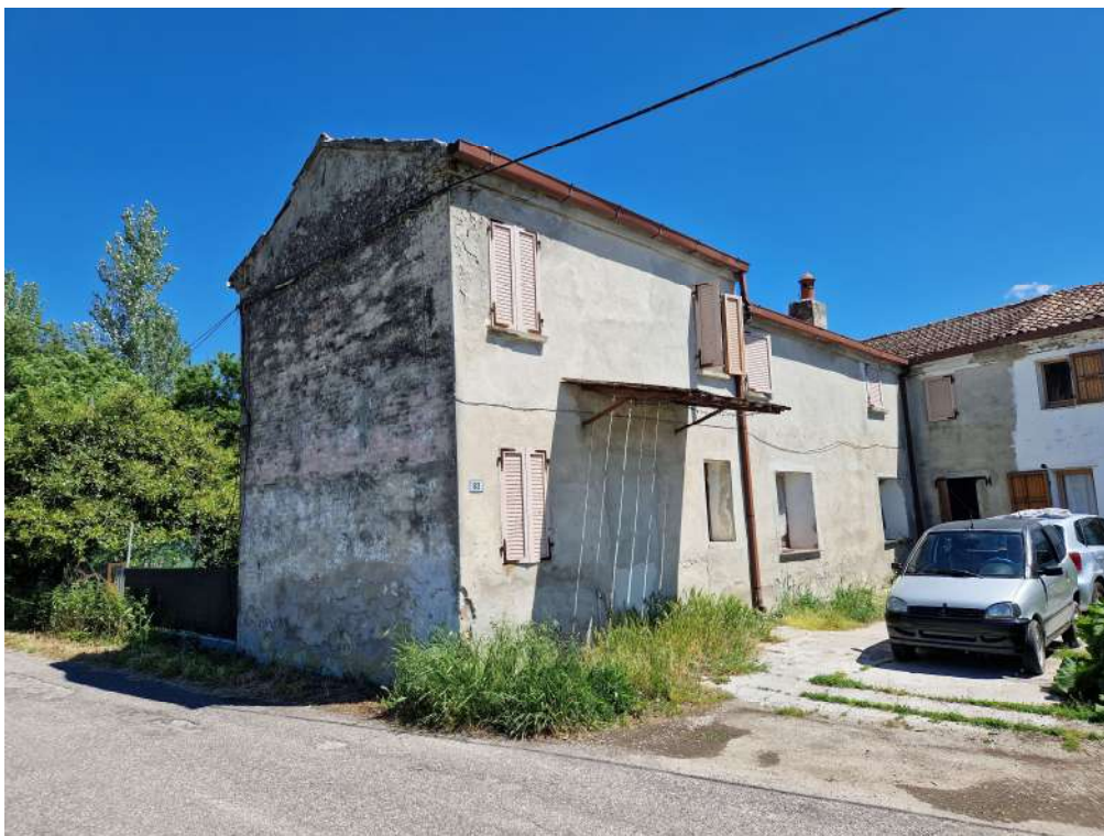
FOTO N. 6 EDIFICIO N. 6 "CA' BUDGHIN" (non oggetto di trasformazioni e non utilizzato)
