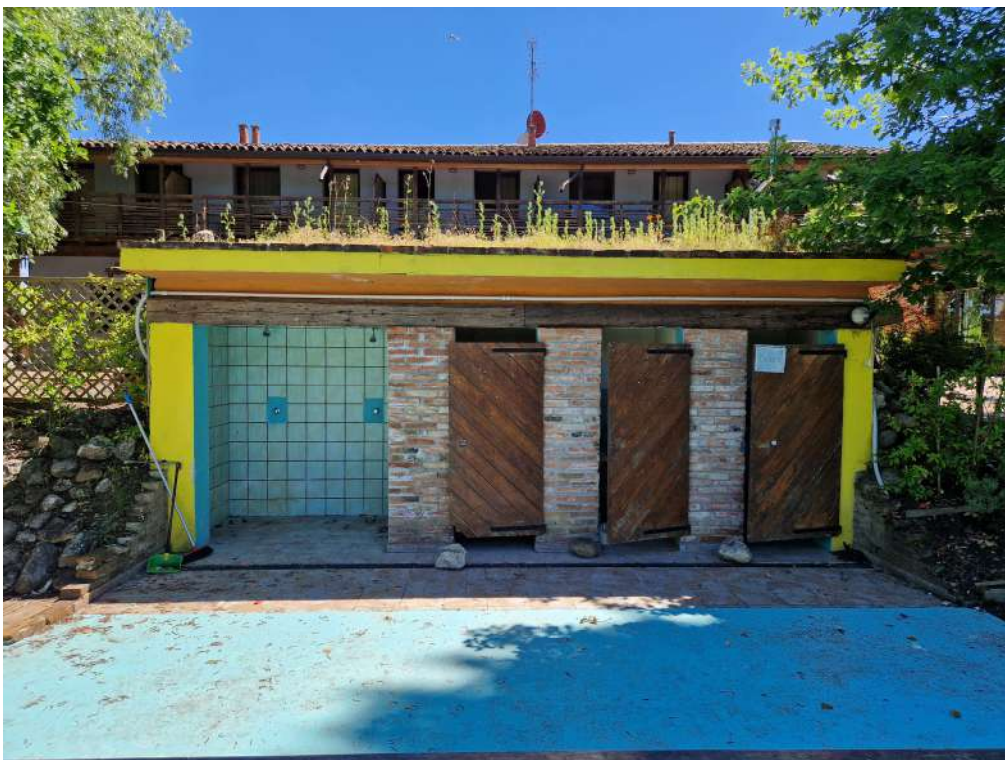
FOTO N. 18 SERVIZI IGIENICI PISCINA/BIOLAGO
