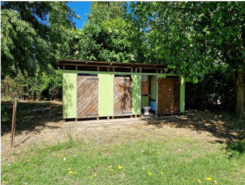
FOTO N. 22 SERVIZI IGIENICI (servizi igienici oggetto di rimozione, zona nord Lago Tramonto)
