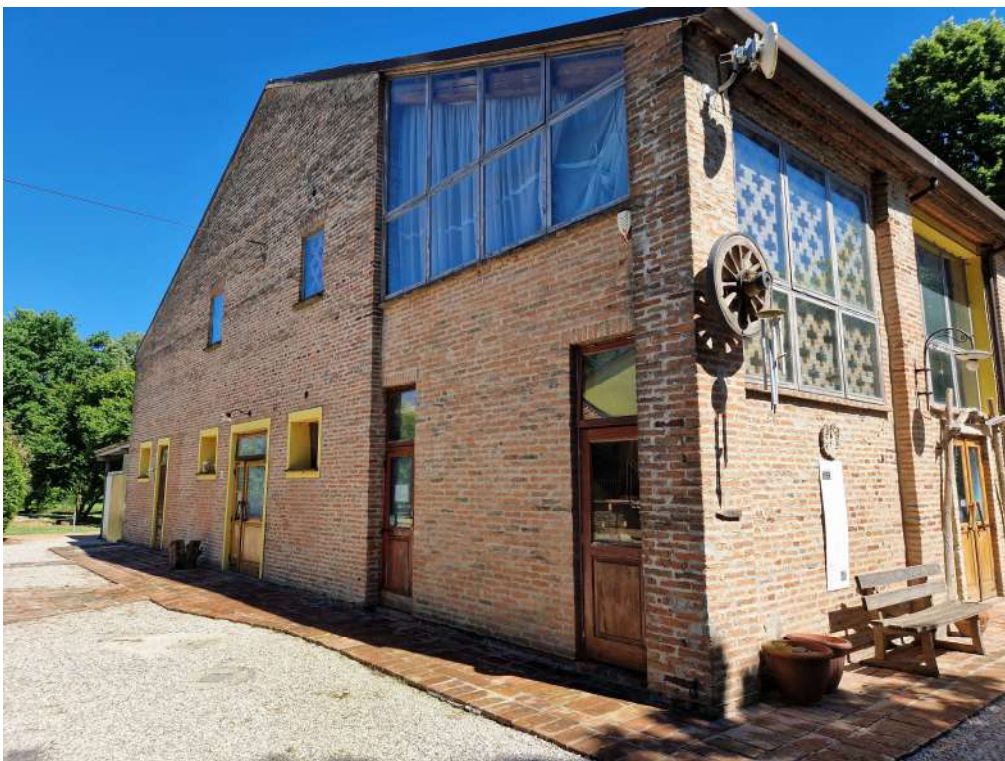
FOTO N. 2 EDIFICIO N. 2 "FIENILE" (oggetto di ristrutturazione del ristorante al piano terra e realizzazione n. 5 alloggi al piano primo)
