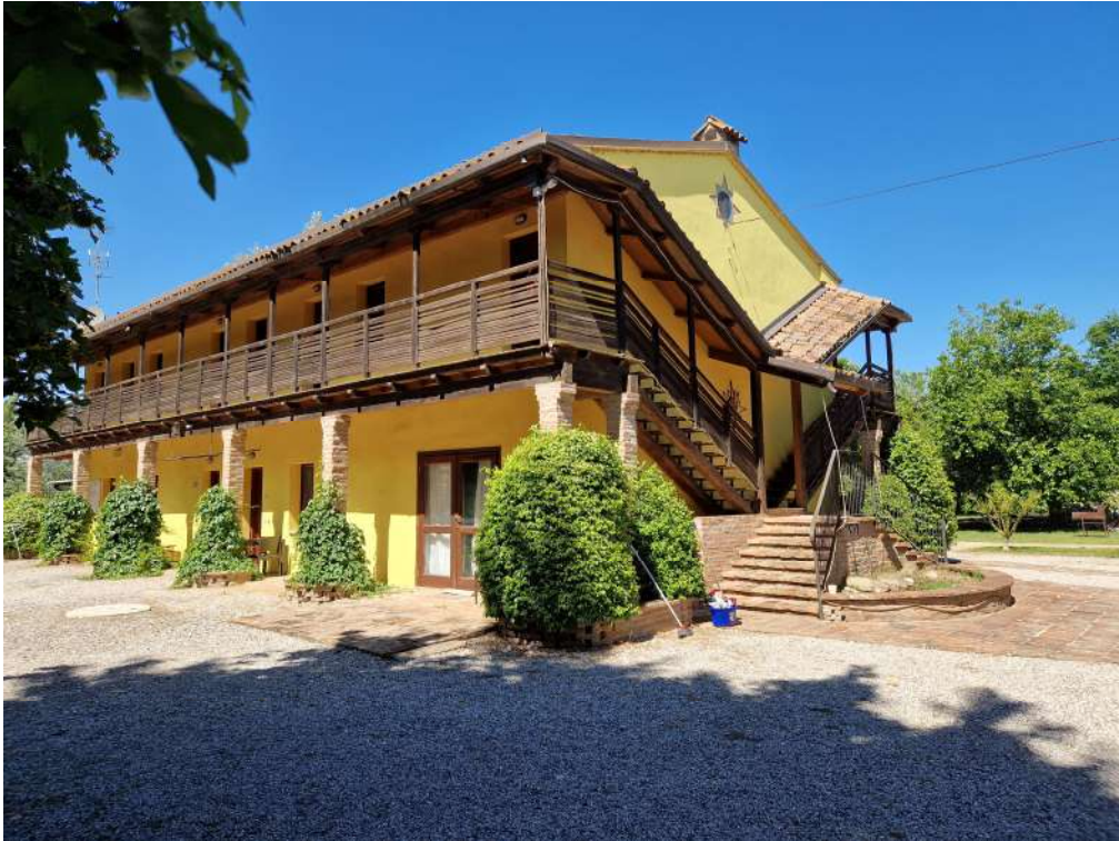
FOTO N. 3 EDIFICIO N. 3 "CA' ALBA" (oggetto di ristrutturazione di entrambi i piani per realizzazione n. 8 alloggi)
